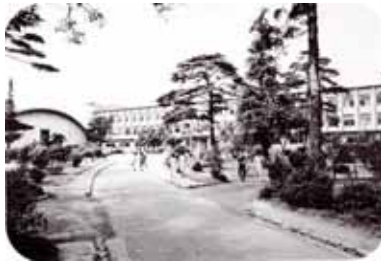
国立音楽大学(場所：現在の国立音楽大学附属中学校・高等学校、国立市)鉄筋コンクリート造りの新校舎とかまぼこ型の講堂(音楽堂)1962年頃。当時三多摩随一の音楽堂として知られ、特に、土曜コンサートは国立町(国立市)の名物であった。 (出典：国立音楽大学創立 70 周年記念絵葉書)
